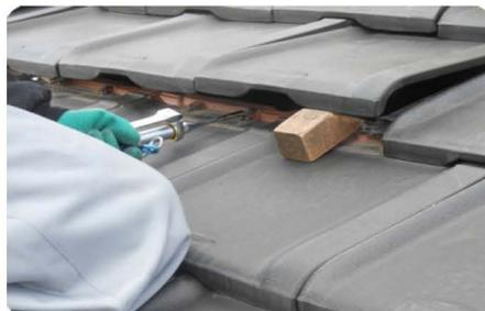
**2** 目視確認の上、ソーラーバールを差し込んで釘頭を係合し、端部をハンマーで毟打して食い込ませる。
