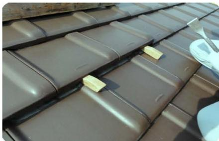
**1** 平コテ等で瓦のすき間に差し込み、開口部を設け、キャンバー等で保持する。
